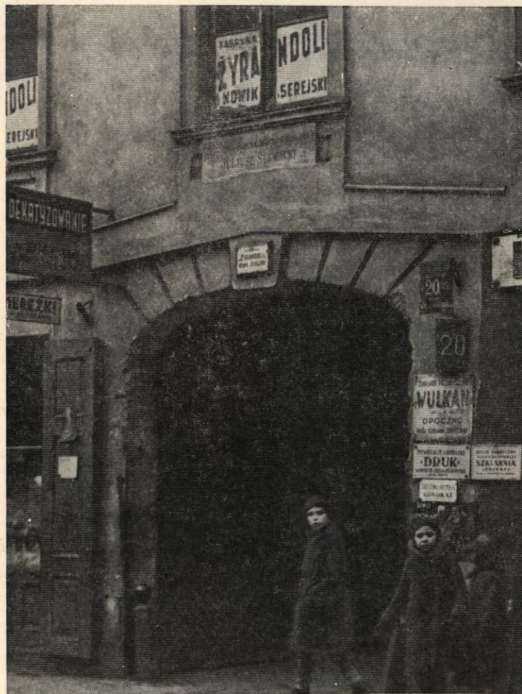
Warszawa, nieistniejący dziś dom przy ul. Elektorальной 20 (755), w którym mieszkał Juliusz Słowacki od października 1829 do marca 1831 r. Tu powstała Maria Stuart. (Fotografia z roku 1927). Upřednio mieszkał Słowacki przy ul. Miodowej w Pałacu Paca.
