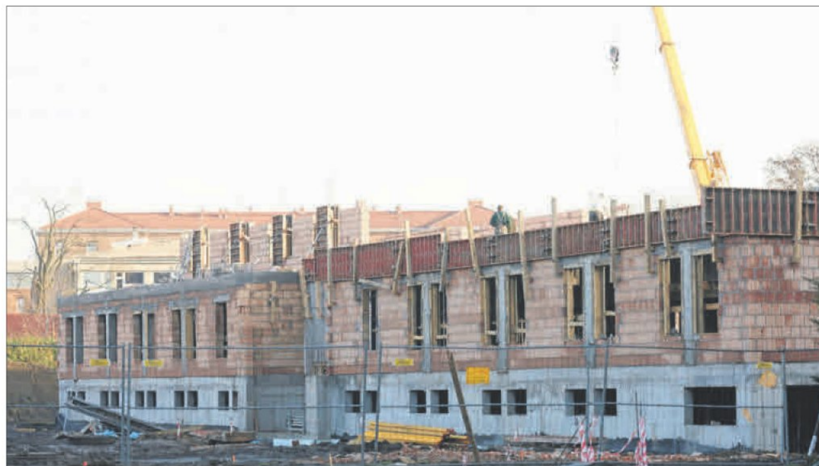
Dwie kondygnacje Domu Seniora Artysty już są. W 2019 roku pojawią tu pierwsi mieszkańcy
