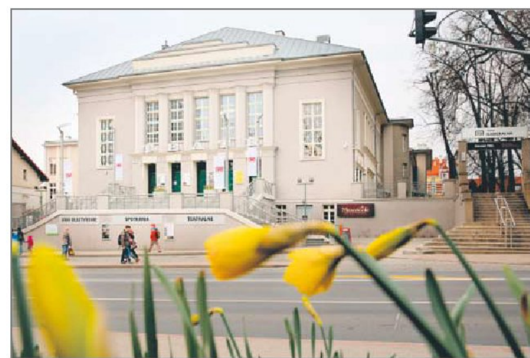
♦ Wzniesiony w 1925 roku budynek teatru po remoncie
