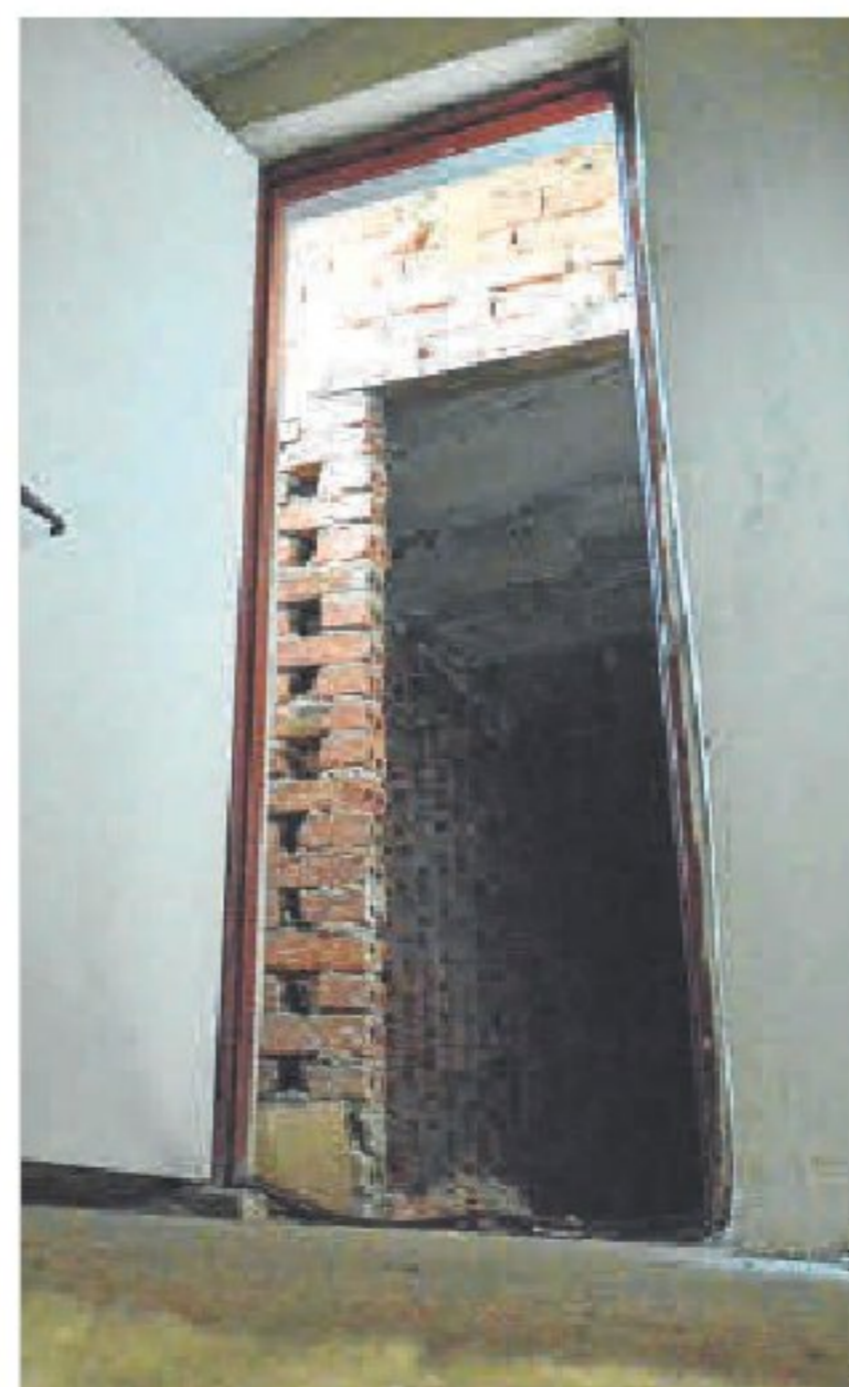
► Wejście na strych, gdzie są elementy z surowej cegły.
