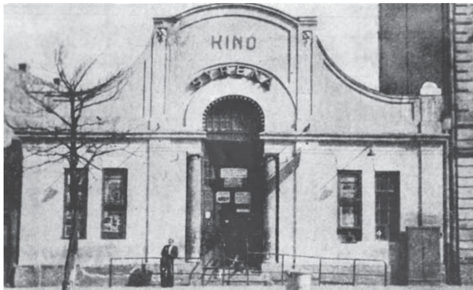
Budynek przy ul. Inżynierskiej 4 na Pradze, pierwsza siedziba Teatru m. st. Warszawy. Fot. koniec lat 40. XX w.
