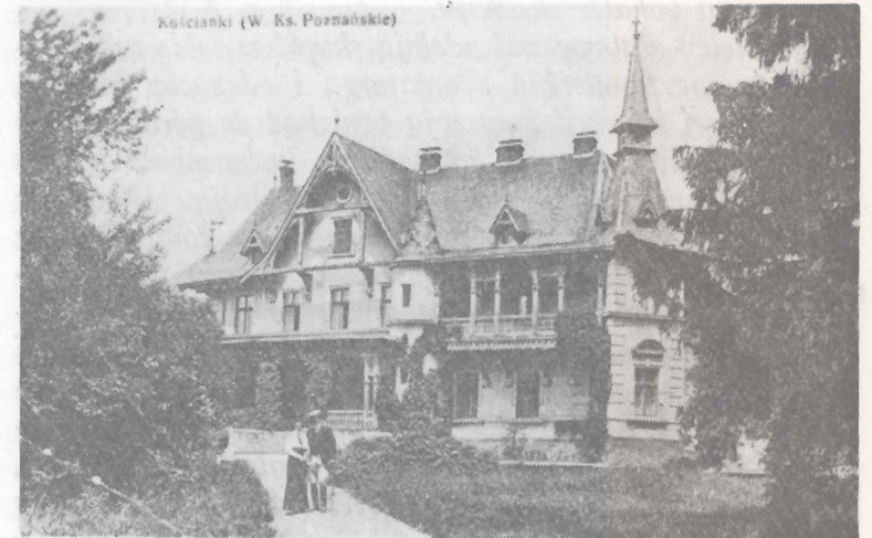
Dom Hulewiczów w Kościankach
